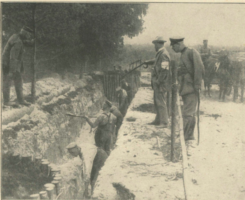
Armierungsoldaten beim Ausschachten eines Schützengraben:
