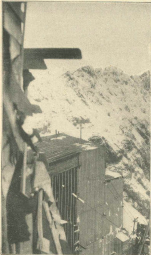
Die Bergstation in 2800 Meter Höhe. In diesem Holzgebäude arbeiten Tag und Nacht sechzig Mann beim Zementieren.
