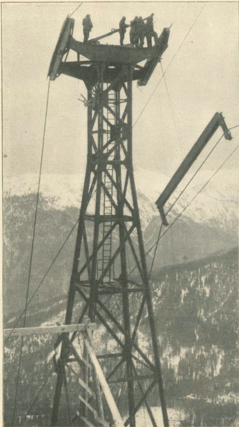
Auflegen des fünfunddreißigtausend Kilogramm schweren Seiles auf den 32 Meter hohen zweiten Träger.
