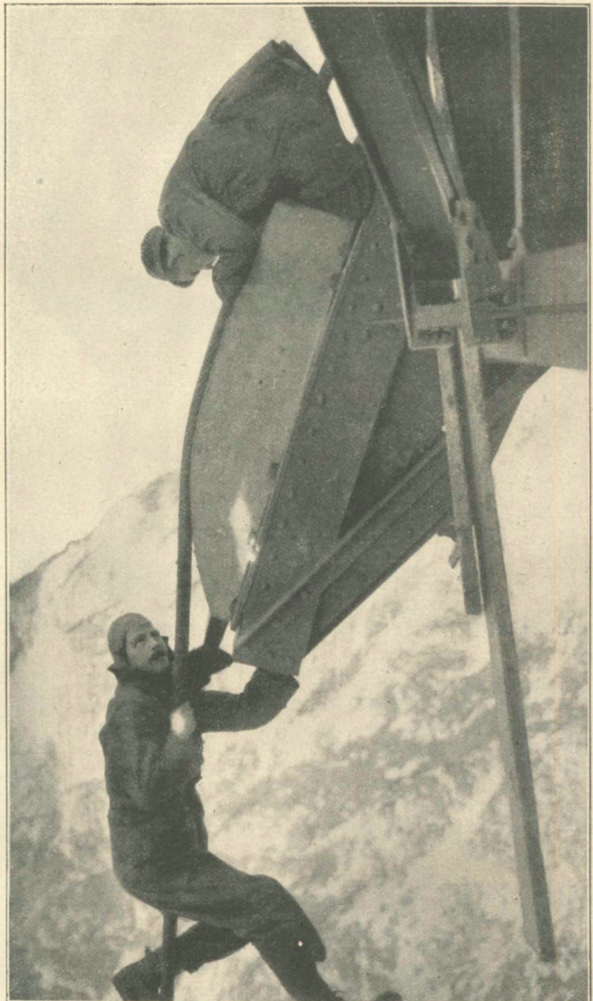
Vom Bau der Zugspitzen-Bahn: Gefährliche Arbeit beim Seilauflegen auf den vierten Träger.
