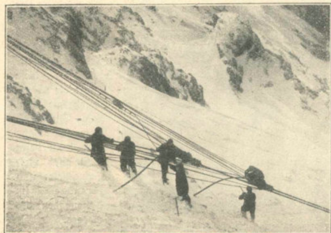
Die Seilverankerung unterhalb der Bergstation. Aufnahmen für die „Berliner Illustrierte“ von A. & E. Frankl.
