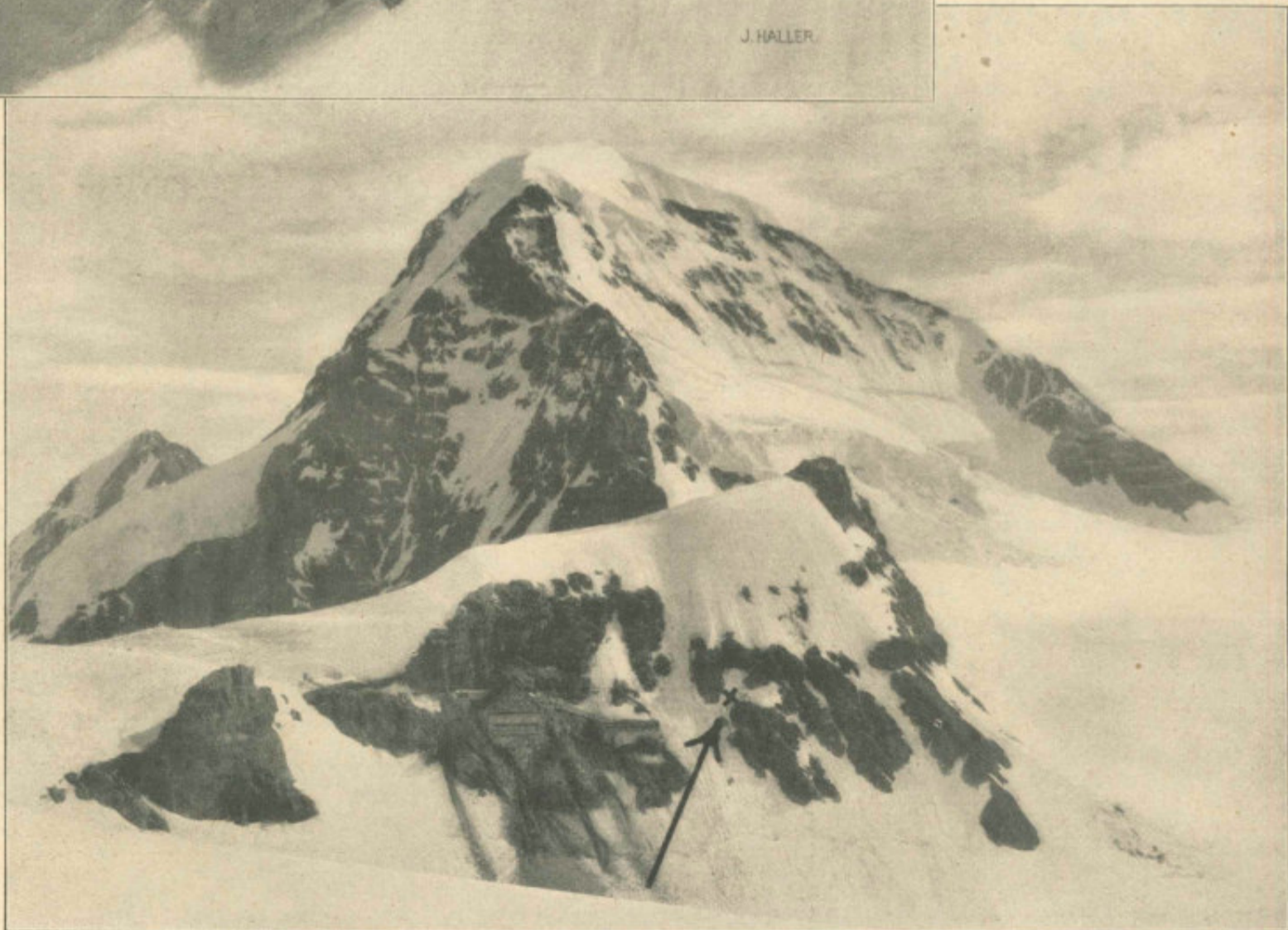
Der Bau der neuen Forschungs-Warte auf dem Jungfraujoch am Felsenhange der Sphinx in 3460 Meter Höhe. Oben: Die Warte mit dem Observatorium. Unten: Der Pfeil zeigt die Stelle am Felsen an, wo die Höhenwarte erbaut wird. Im Hintergrund der Mönch (4105 M.).
