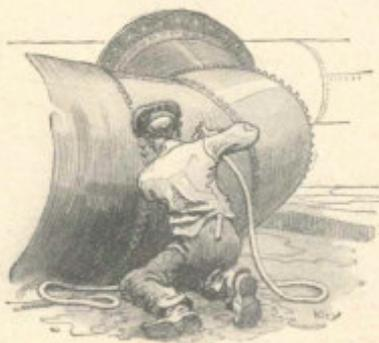
Wo früher Niet um Niet mit unendlicher Mühe von Hand geschlagen werden mußte, arbeitet der moderne Pfeilstschammer mit zweitausend Schlägen in der Minute.
