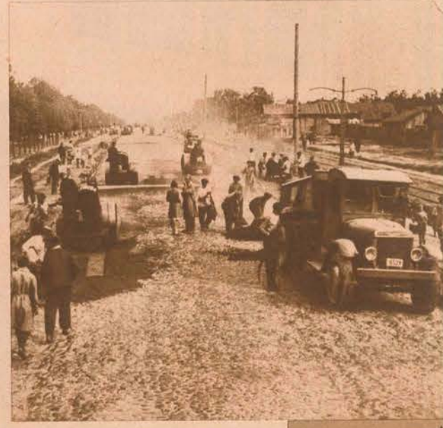
Das berüchtigt schlechte Pflaster des alten Moskau verschwindet. Man begnügt sich nicht mehr mit dem Ausbessern, sondern sorgt für dauerhafte Pflasterung (Asphalt Quarzwürfel)
