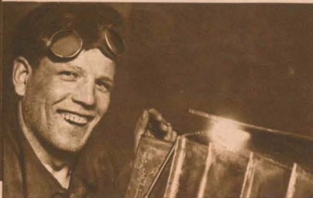
Der Stoßarbeiter Afenin in der Schweißabteilung des Elektrowerkes. Die 15 000 Arbeiter des Moskauer „Gigant“ (so wird der Elektrosawod genannt) haben den Fünfjahresplan in 2 1/2 Jahren durchgeführt. Es ist die erste Fabrik der Sowjet-Union, deren Arbeiter im Januar 1931 kollektiv die höchste Auszeichnung, den Leninorden, bekommen haben neben den besonderen Urlaubs- und Lohnvergünstigungen, die den Stoßarbeitern zuteil werden
