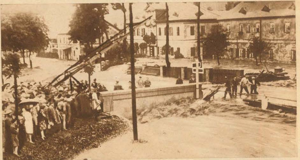
Eine schwere Unwetterkatastrophe ereignete sich im westlichen Erzgebirge. In Johannegeorgenstadt spülte der Wolkenbruch mehrere Häuser weg, von der Gewalt des Sturmes wurden sogar hohe steinerne Ufermauern streckenweise niedergebissen
