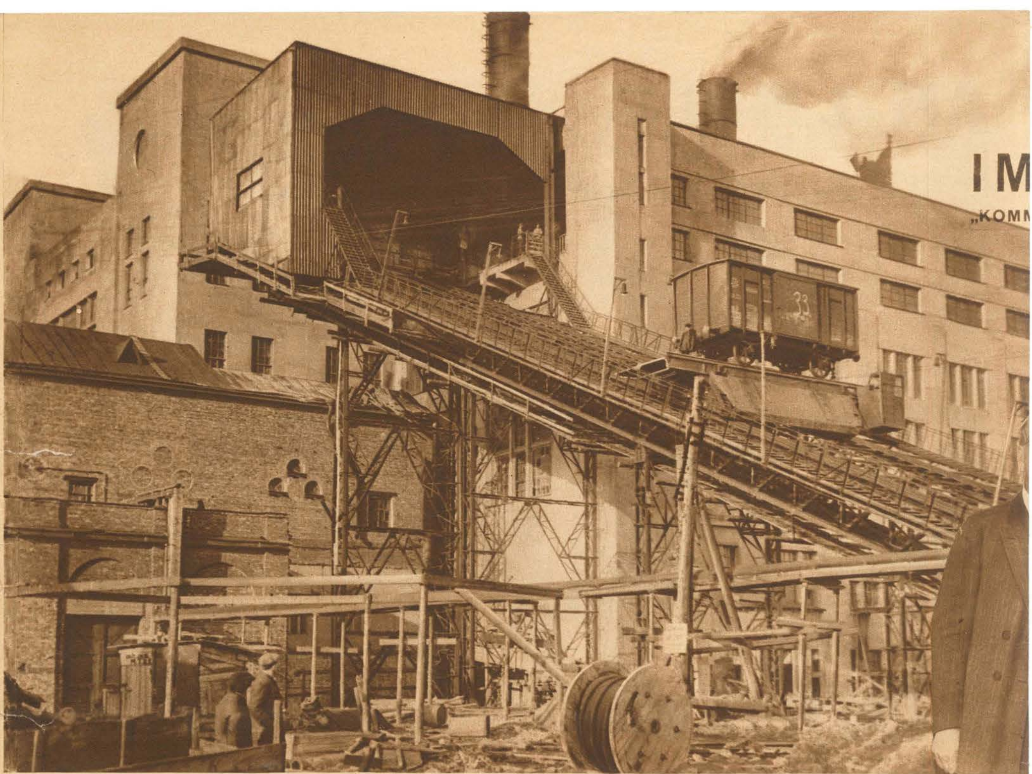
Das Elektrizitätswerk „Krasny Oktjabr“ (Roter Oktober) ist das erste große Torfkraftwerk in Leningrad. Es deckt zusammen mit dem Wasserkraftwerk Wolchow den größten Teil des Kraftverbrauches des wichtigsten Leningrader Industriebezirkes. Diese beiden Kraftwerke genügen aber nicht bei dem raschen Entwicklungstempo des Verbrauches an elektrischer Kraft. Es ist darum bereits mit dem Bau weiterer Werke begonnen worden
