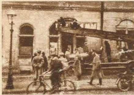
Auf Veranlassung der Polizei entfernt die Feuerwehr Transparenz, die an der Hausfront des Partibüros der KPD in Dresden für den Maiaufmarsch warben
