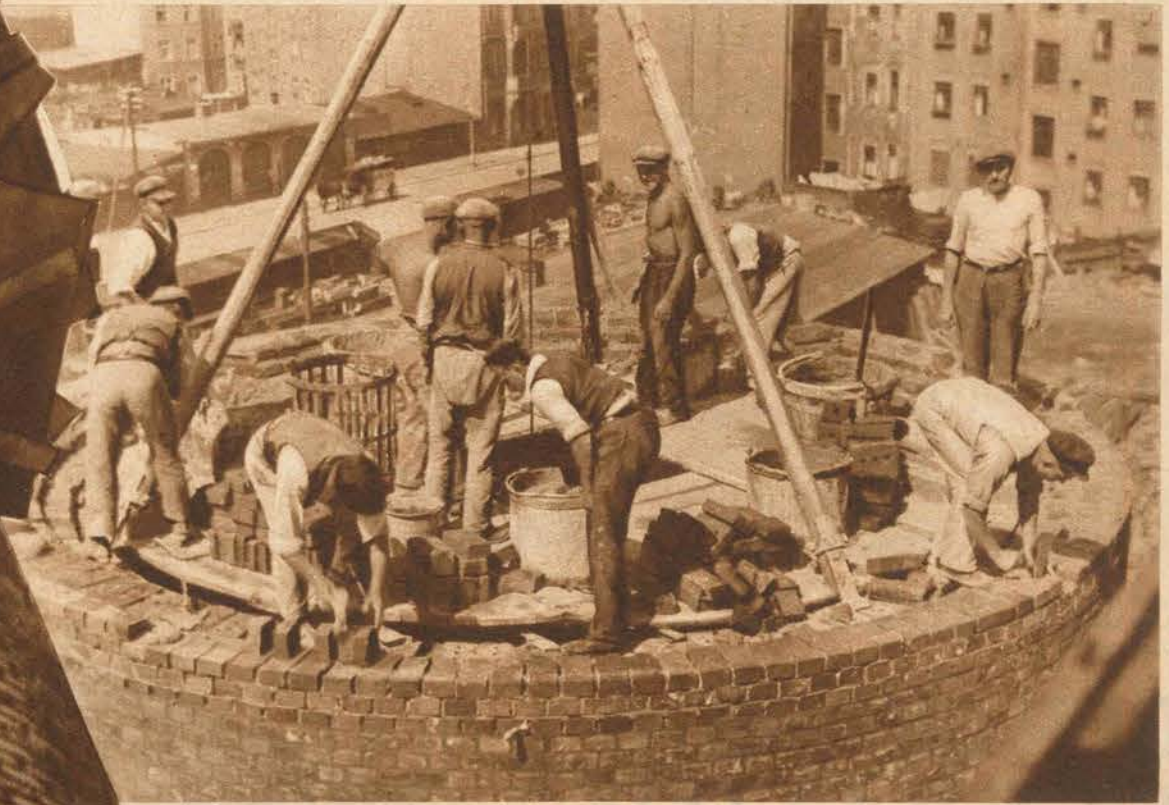
Der Unterbau des Schaftes oberhalb der Erdgleiche wird aus guten scharfgebrannten Backsteinen hergestellt, der Schaft absatzweise aus einzelnen Trommeln zusammengesetzt, die aus lotrecht durchlocherten Ringsteinen bestehen
