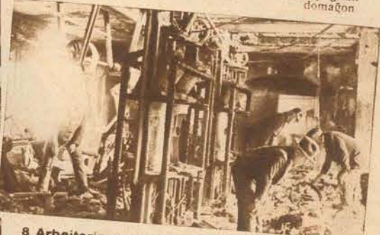
8 Arbeiterinnen wurden bei der Explosion in einer Magdeburger Sacharinfabrik getötet, weitere Arbeiterinnen zum Teil schwer verletzt. Die Explosion ereignete sich an einer Mischtrommel, die außer anderen Chemikalien Schwefel und Salpeter verarbeitete 8 laboristinoj estis mortigitaj ĉe eksplodo de Magdeburga sakarinfabrike, aliaj laboristinoj parte grave vunditaj. La eksplodo ekis ĉe mikstamburo, kin krom aliaj kemiĵoj prilaboris sulfon kaj salpetron.
