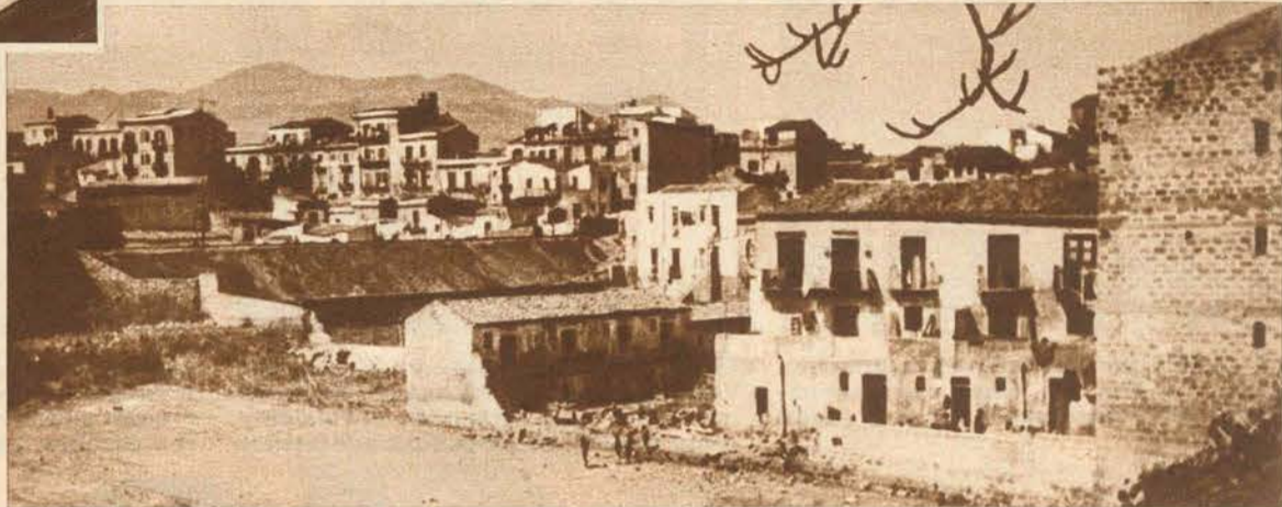
Eingang in das vom Unwetter betroffene Wohnviertel. Von links stürzte sich eine vier Meter hohe Wasserwand auf die Häuser im Hintergrund. Das kleine Haus in der Mitte war völlig überflutet
