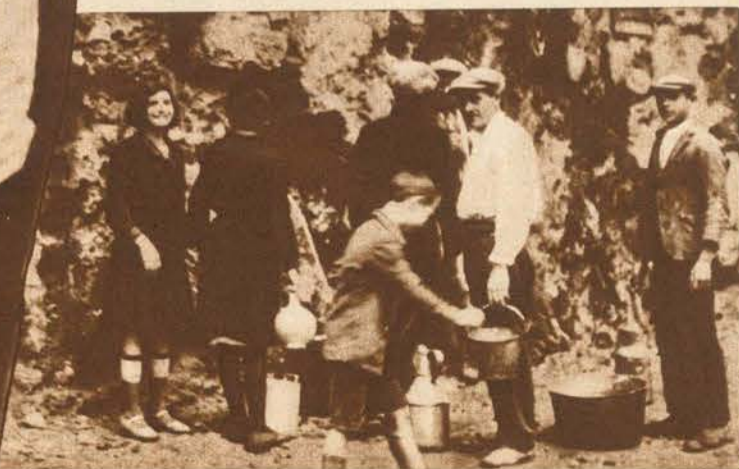
Die seit einem Monat zerstörte Wasserleitung ist noch nicht in Stand gesetzt. Ganz Palermo muß sich aus Quellen und Brunnen versorgen
