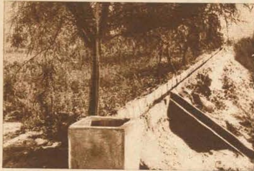
Wo die Konzessionäre mit riesigen Regierungssubventionen ihre Betonkanäle anlegen, ist dem kargen Boden allerhand abzugewinnen. Italienische Siedlung auf geraubtem Land in der Oase Tagiura
