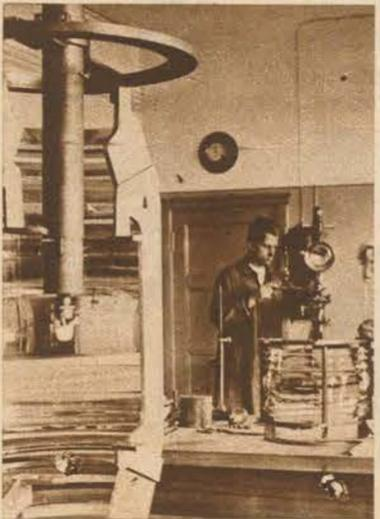
Die Leuchte wird in der Werkstatt zusammengebaut. Hier sieht man deutlich den in senkrechter Lage angebrachten Gasglühlichtbrenner
