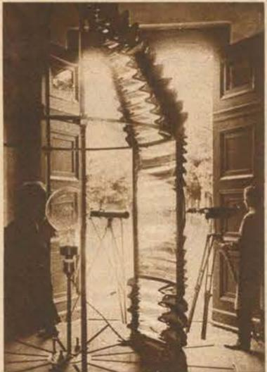
Als Lichtquelle dient ein Gürtelleuchter mit Glühstrumpfsatzlampe, die sogenannte „Tannenbaumlampe“; für den Unterbau hat man einen Drehtisch mit Kippe verwendet. Durch das Tor Blick auf die Lichtmeßbahn. Am Eingang stehen 2 Photometer, die die Stärke der Lichtquellen messen
