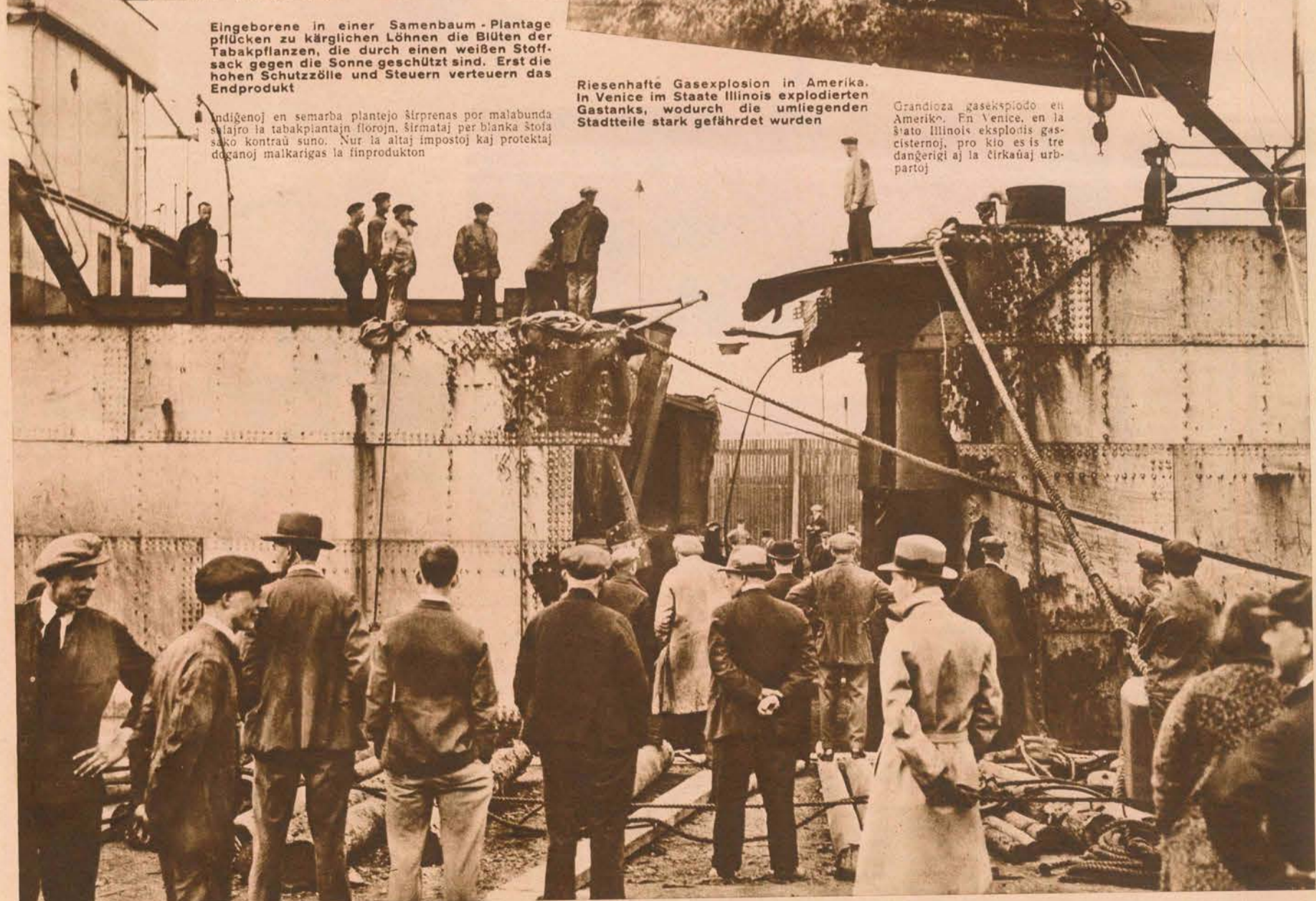
Der 10-Tonnen Dampfer „Nurturetonu“, der größte Eindecker der Welt, lief bei Dungeness im Nebel auf und brach mittendurch. Die beiden Schiffshälften wurden auf das Trockendeck von Tilbury geschleppt und nunmehr wieder zusammengefügt
