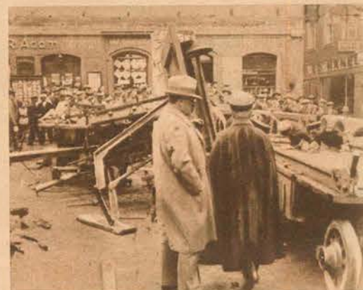
Wieder eine Folge des Antreibersystems. In Dresden stürzte der Kran beim Abmontieren einer Liftsäule um, wobei ein Arbeiter getötet, ein zweiter verletzt wurde. In den Zeitungen wird man wieder von einem „unglücklichen Zufall“ lesen
