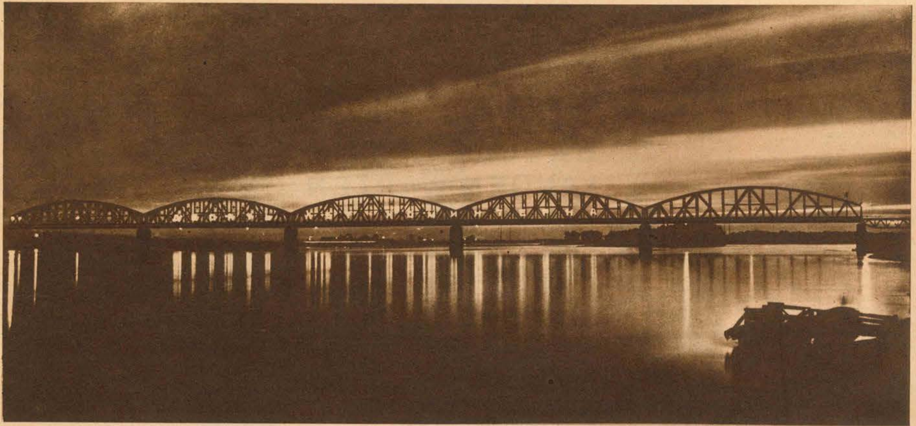
Neue Brücke über dem Fluß Irtysh in Sibirien, die für die Turksib-Bahn gebaut wurde
