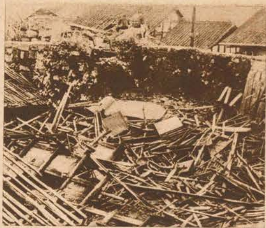
Hankau gleicht einer Wüste. Die andrängenden Fluten brachten tausende von Häusern zum Einsturz, die Menschen wurden von den abbröckelnden Steinen und brechenden Balken erschlagen
