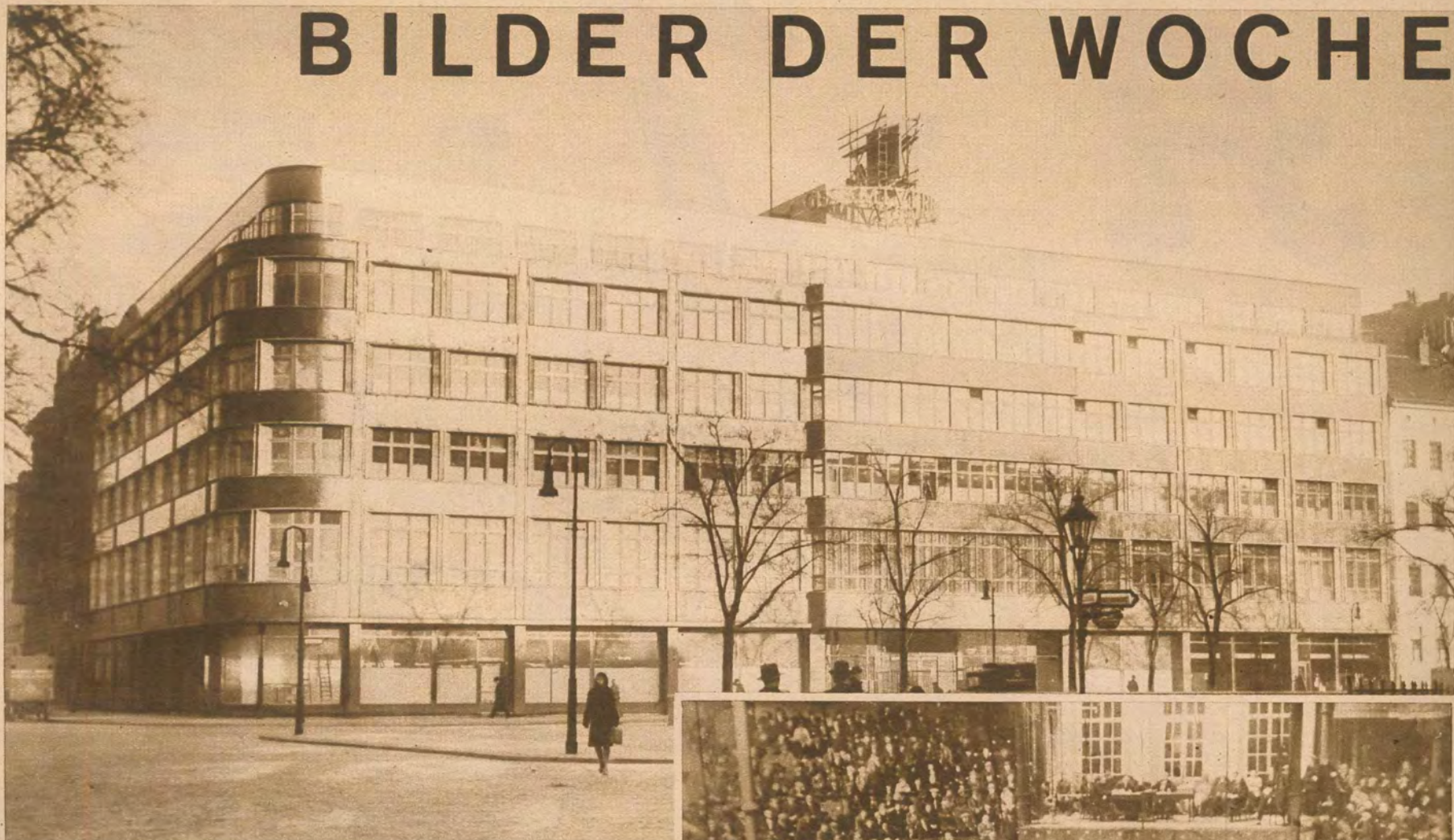
Wofür im kapitalistischen Deutschland Geld da ist . . . Die reformistischen Gewerkschaftsführer errichteten in Berlin am Engelufer diesen Monumentalbau, wahrscheinlich um damit zu dokumentieren, daß sie die Not ihrer Mitglieder ziemlich unberührt gelassen hat
