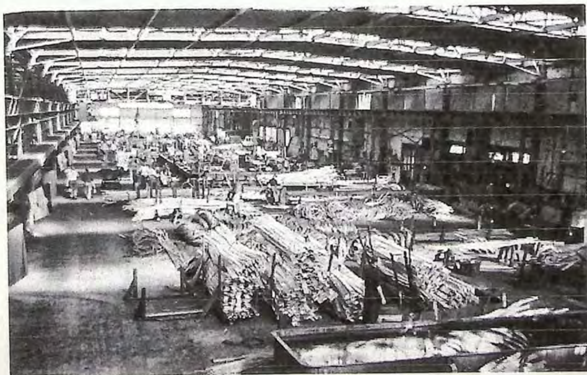
Neue Halle Rohrzug
