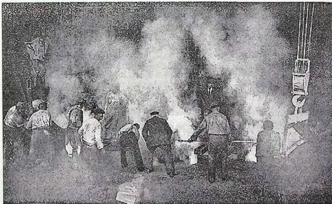
Teilansicht der Gießerei: Vergießen eines 400 kg schweren Gußstückes aus patentierter Ruelbelbronze
