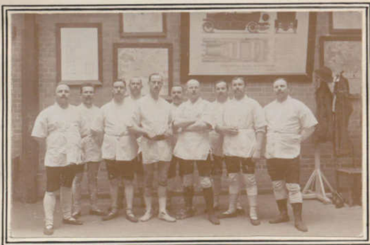
Als Lehrmeister ausgebildete Beamte, von Charlottenburg, Neukölln und Lichtenberg.
