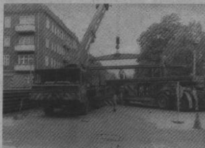
Mittels Schwertransport werden hier Großverbundplatten verladen.
