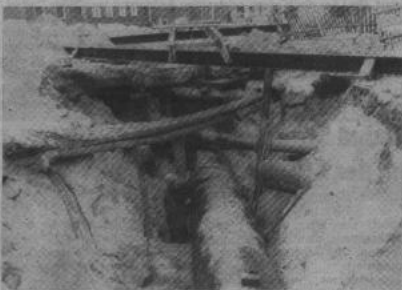
Meister Hans-Karl Schlinke am Schutzrohr für eine 600er Trinkwasserleitung unweit des Siemensknotens.
