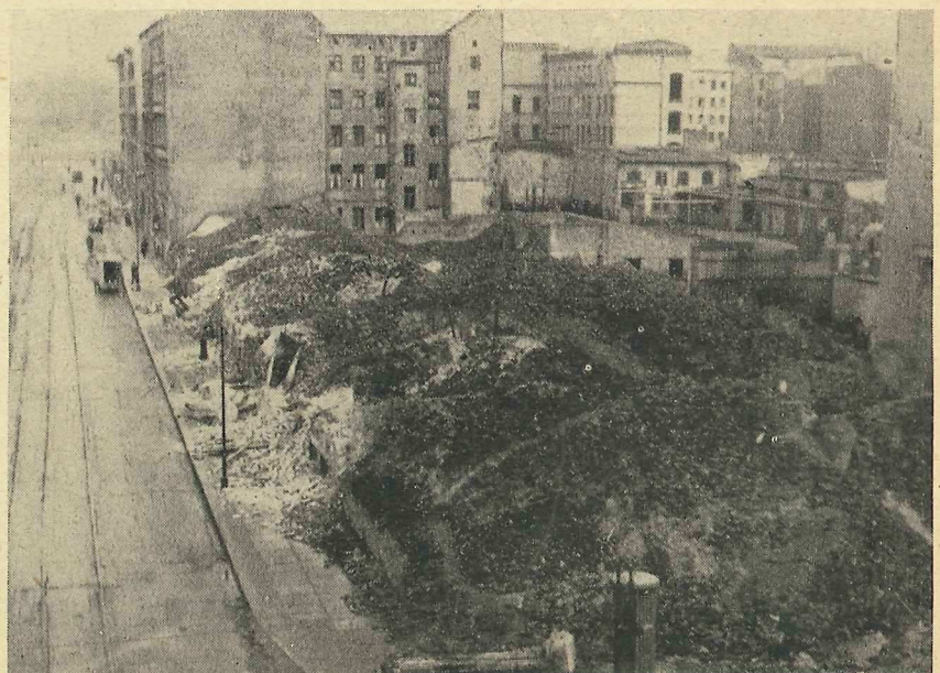
So sah unsere Baustelle am 1. Januar 1952 aus und . . . .
