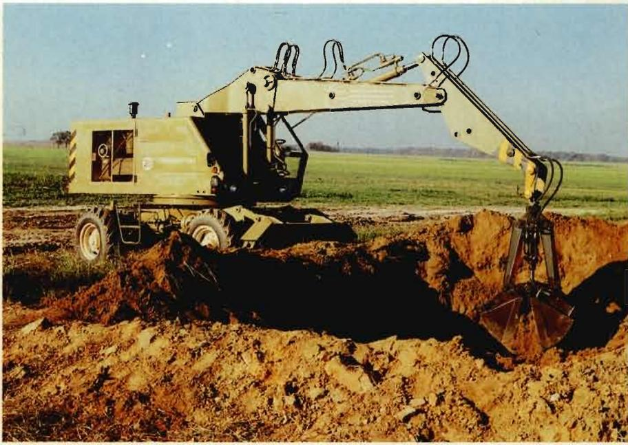
Durchführung von Erdarbeiten mit Greiferschale 0,4 m<sup>3</sup>
